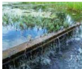
Dagvattendamm med terrassering som blir vattentrappa vid stora regnmängder.
