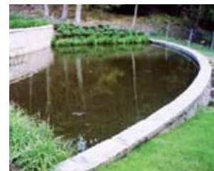
Dagvattendamm med stödmurar av betong och beklädnadsgranit.
